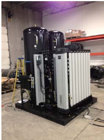
集成的医疗气体处理系统
