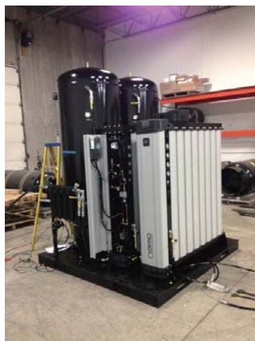
集成的医疗气体处理系统
